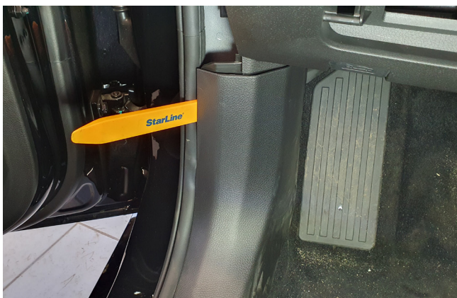
Фото 1.8. Снять накладку левой кик-панели
