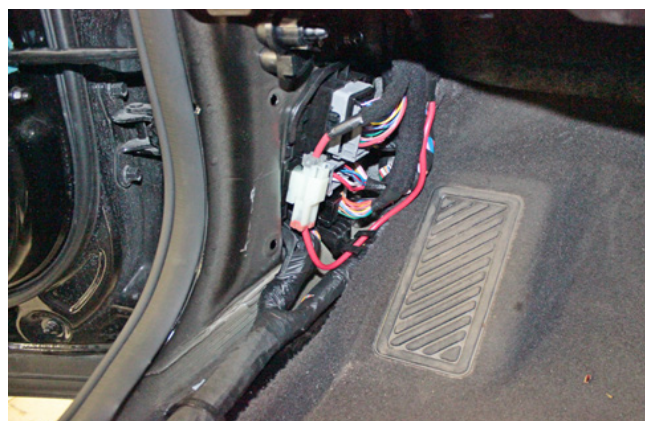
Фото 1.8. Накладка левой кик-панели снята
