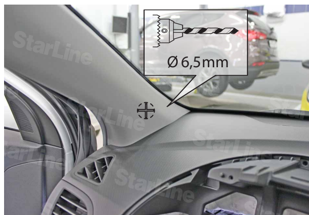
Фото 3.2. Место установки светодиода
