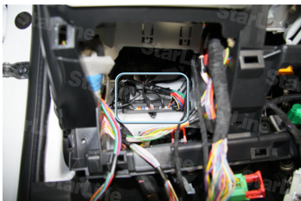
Фото 7. Блок сигнализации за блоком BSI
