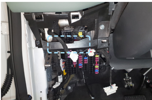
Фото 2.8. Пример расположения центрального блока охранно-телематического комплекса
