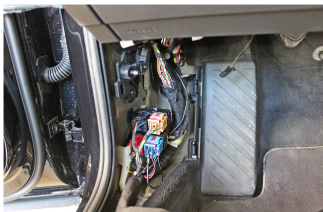
Фото 1.20. Накладка левой кик-панели снята
