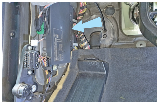
Фото 1.13. Накладка снята. Блок FRM
