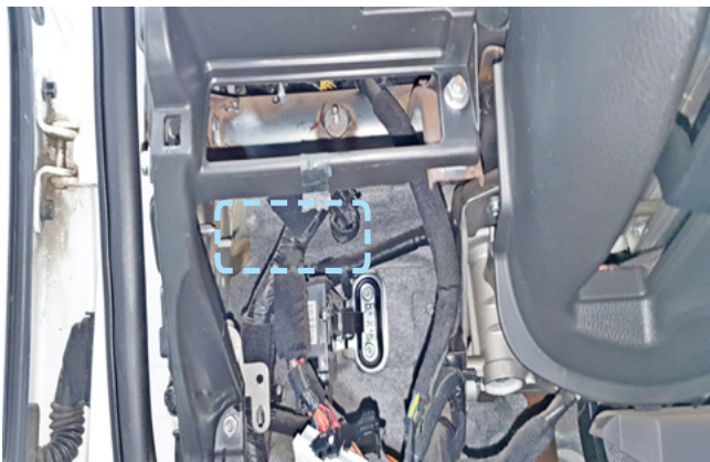
Фото 2.7. Пример расположения центрального блока охранно-телематического комплекса
