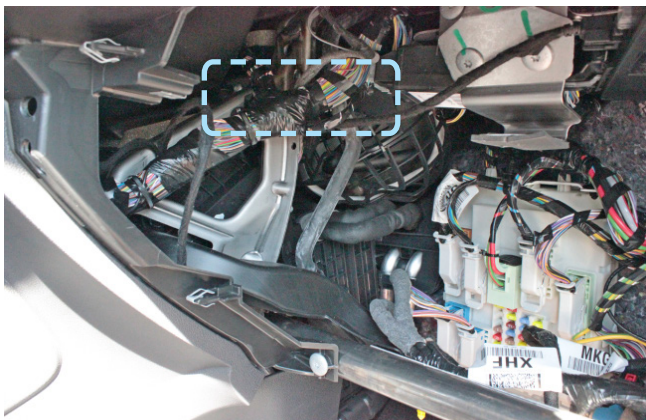
Фото 2.8. Пример расположения центрального блока охранно-телематического комплекса
