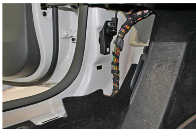
Фото 1.27. Накладка левой кик-панели снята
