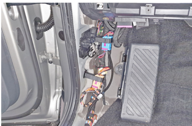
Фото 1.17. Пластиковая накладка левой кик-панели снята
