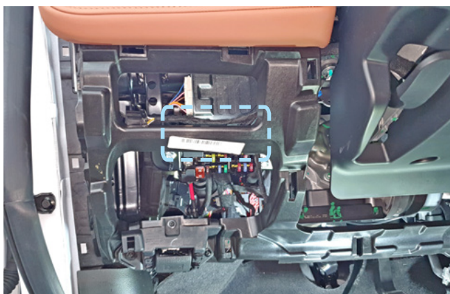
Фото 2.7. Пример расположения центрального блока охранно-телематического комплекса
