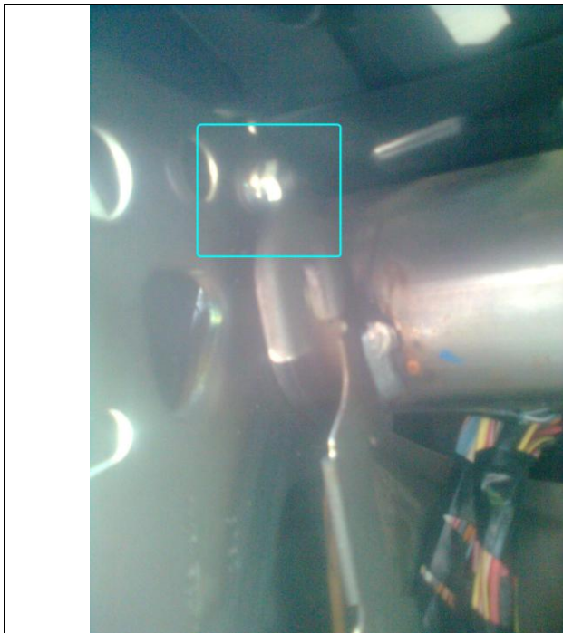
Фото 2.1. Общий провод сигнализации зажимаем под гайку на левом краю поперечной трубы – усилителя жесткости над левой КИК-панелью.
