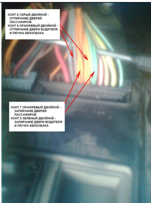
Фото 2.3. В черном узком разъеме PP2 подключаемся к силовым проводам управления Центральным Замком по схеме 2.1
