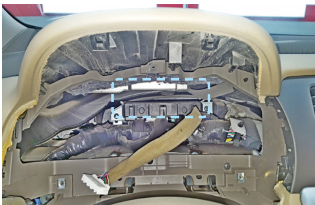
Фото 2.7. Пример расположения центрального блока охранно-телематического комплекса
