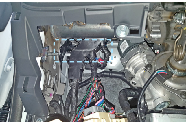
Фото 2.8. Пример расположения центрального блока охранно-телематического комплекса
