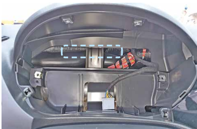
Фото 2.8. Пример расположения центрального блока охранно-телематического комплекса
