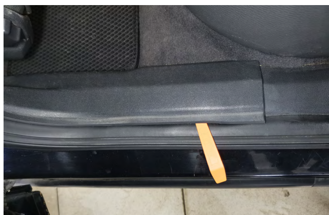
Фото 1.16. Снять накладку порога с левой стороны
