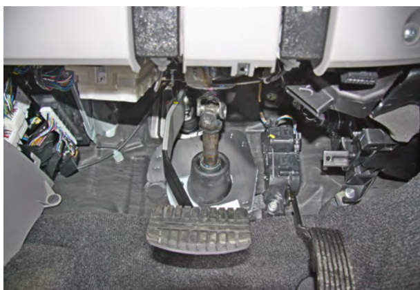
Фото 1.3. Нижняя накладка снята
