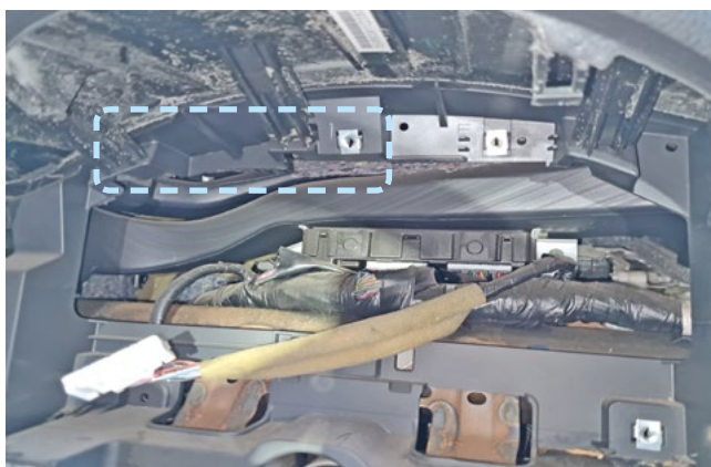
Фото 2.7. Пример расположения центрального блока охранно-телематического комплекса
