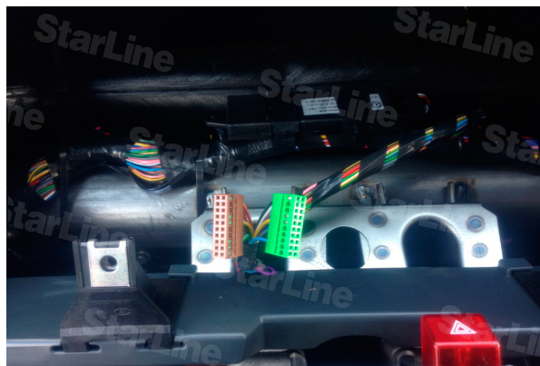
Фото 1.8. Щиток приборов снят- общий вид
