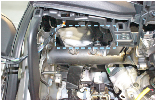
Фото 2.7. Пример расположения центрального блока охранно-телематического комплекса
