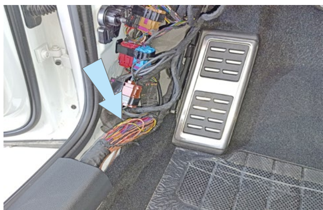
Фото 3.2. Местоположение жгута в левой кик-панели
