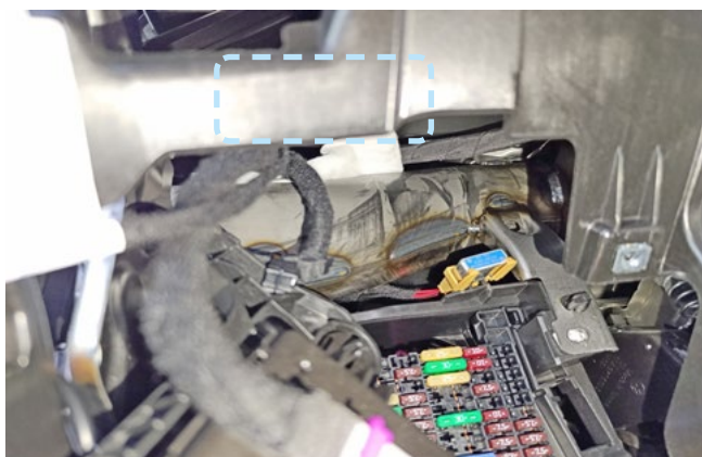
Фото 2.2. Пример расположения центрального блока охранно-телематического комплекса
